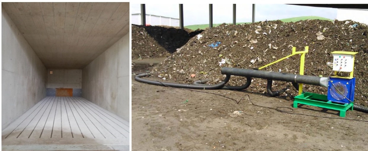
Abb. 13: Trocknungstunnel (links), Belüftungsmodul (rechts) (Quelle: Abfallwirtschaft Vechta)
