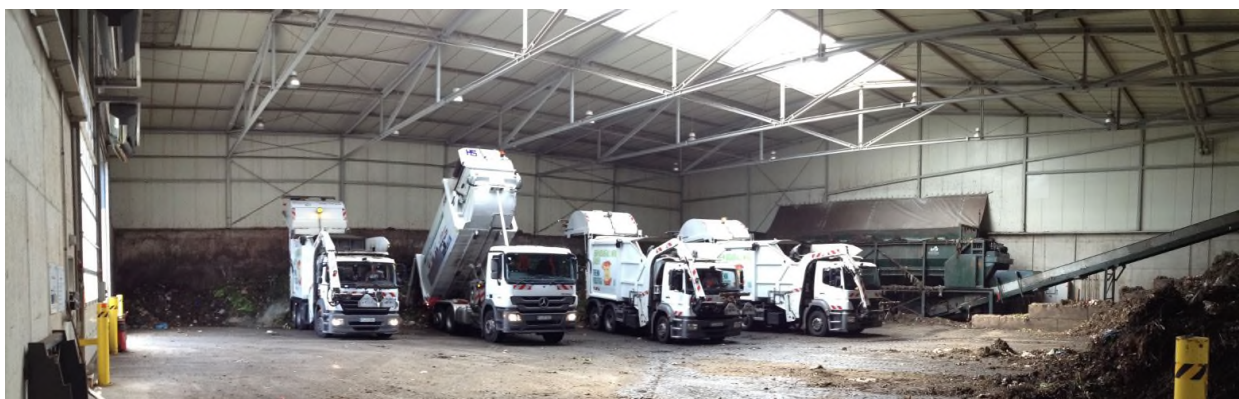
Abb. 104: Anlieferung von Biogut in der Praxis
